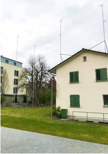
Verdichten bedeutet mitunter auch, bestehende Bauten aufzustocken. Foto: H. Haag, VLP-ASPAN
